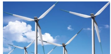
Monitoreo de velocidad de aerogeneradores
